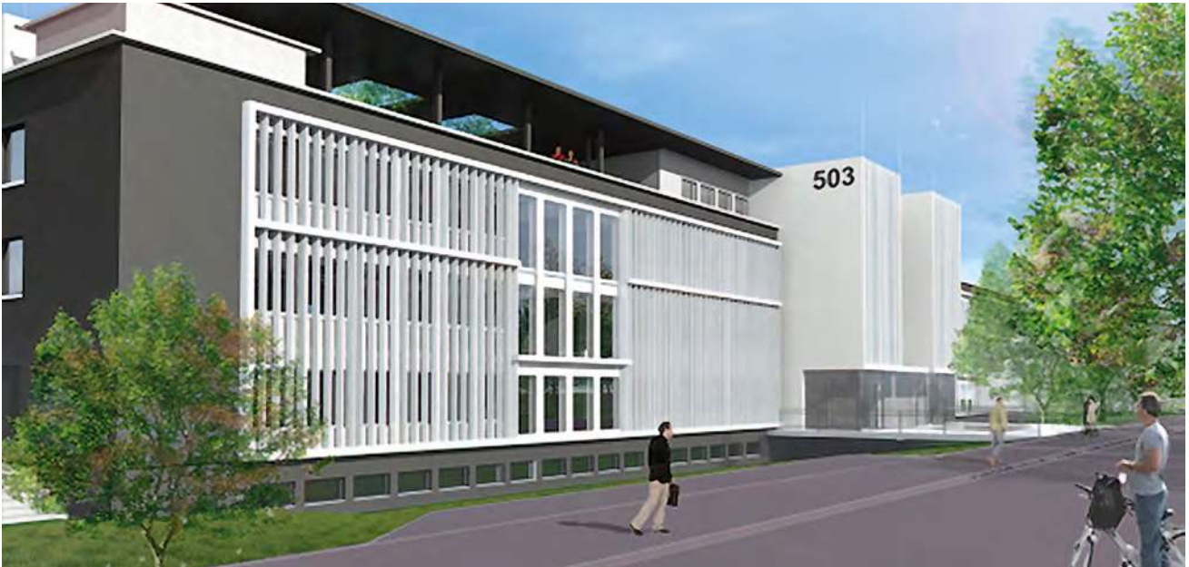
I Bâtiment 503 à Orsay entièrement rénové fin 2023
