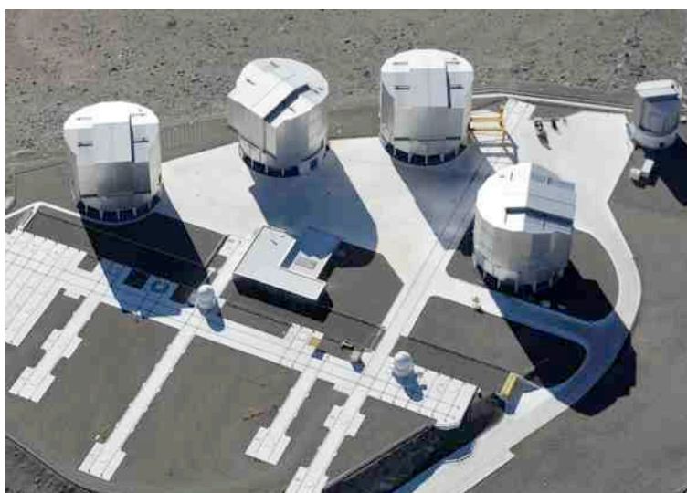
Fig. 2 : le site du Very Large Telescope de l'ESO au mont Paranal au Chili. Deux des 4 AT déplaçables sur des rails sont visibles en plus des 4 UT.
